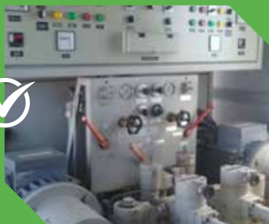
Modernización tableros control con puertas Portezuelo Grande
