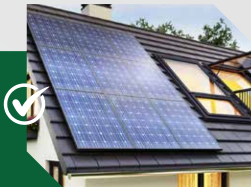
Automatización y eficiencia energética
